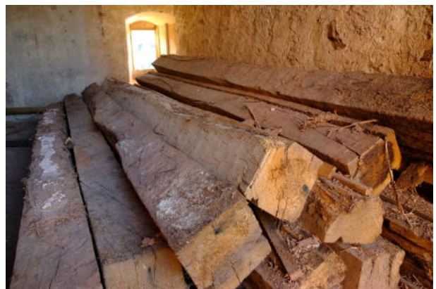
Abb. 3 Die mächtigen Deckenbalken aus dem Arkadenbau wurden nach ihrem Ausbau im Erdgeschoss des Gebäudes zwischenlagert. Man sieht im Schräglicht sehr schön die flächigen Schlagfazetten eines Behaubeißes, mit denen die Balken noch saftfrisch zugerichtet wurden. Im Querschnitt der Balken kann man an den Trockenrissen erkennen, dass die Balken jeweils aus einem Viertelstamm gefertigt wurden. (Foto Gies)
