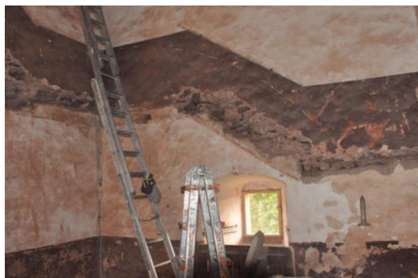
Das Treppenhaus im Arkadenbau nach Ausbau der Barocktreppe
