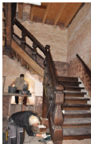
Einbau der restaurierten Treppe
