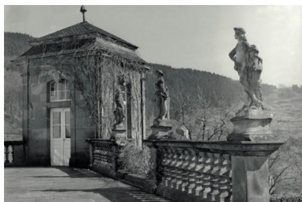
Blick auf den nordöstlichen Pavillon (Foto ca. 1970). Die Balustrade ist teilweise herausgebrochen.
